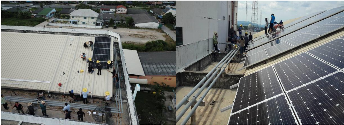
ภาพที่ 4 แสดงความร่วมมือร่วมใจลงแรงเรียนรู้ในปฏิบัติการติดตั้งโซลาร์เซลล์บนหลังคาโรงพยาบาลจะนะ
