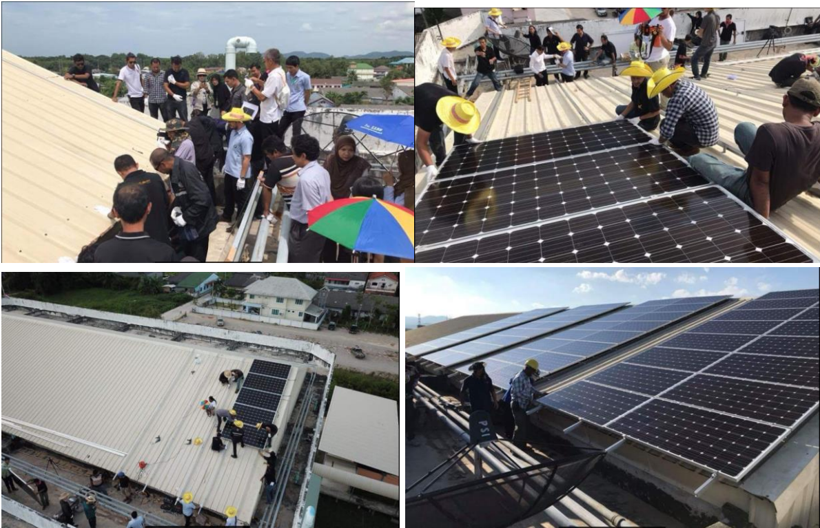
รูปที่ 8 แสดงการติดตั้งโซลาเซลล์
